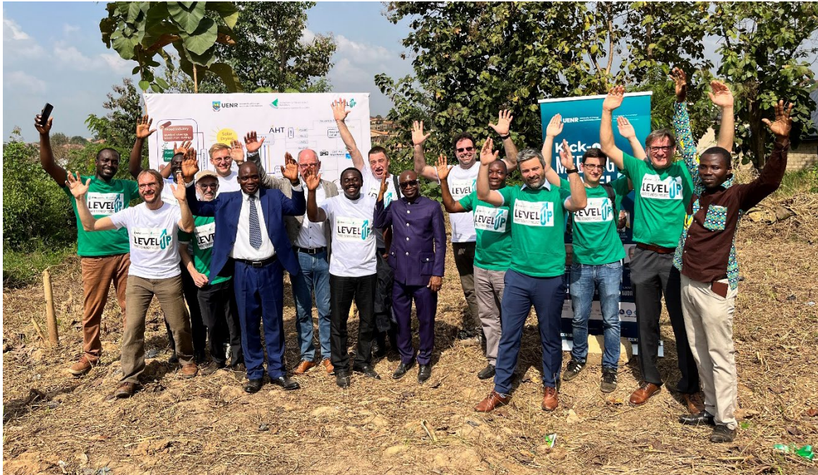
Abb. 14: Das LevelUp-Projektteam beim symbolischen Spatenstich zur Eröffnung des Projekts in Sunyani, Dezember 2022 (Foto HFR)
